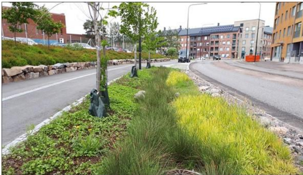
Kuva 10. Esimerkki biosuodatusrakenteesta (© Ramboll)
